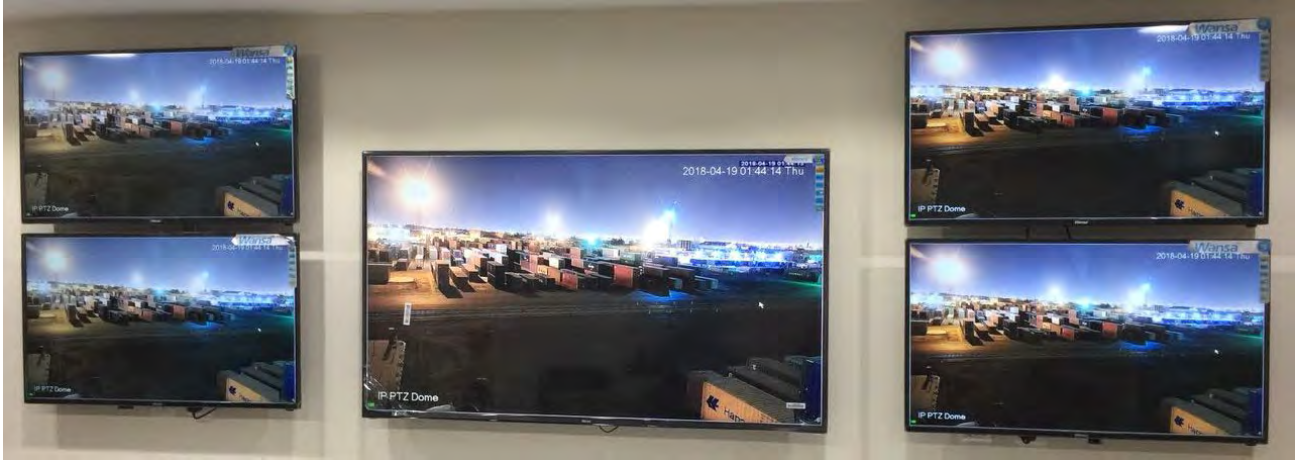
Riyadh Dry Port, Riyadh.
